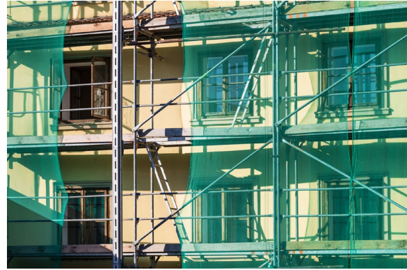
Figura 8) Reti per ponteggi
